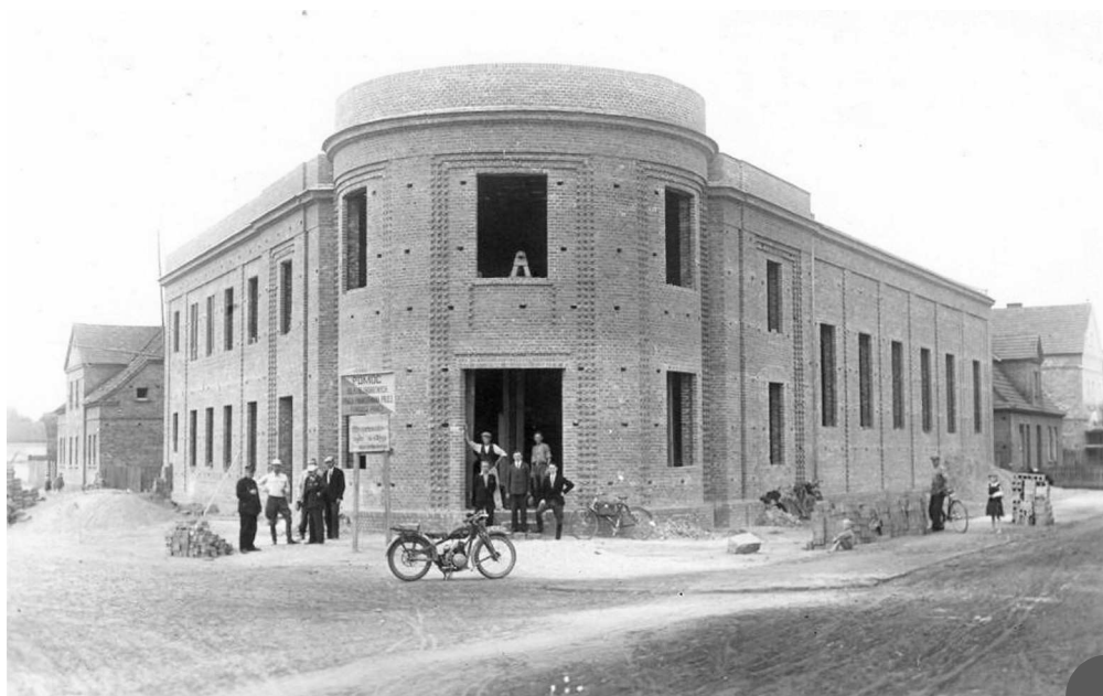
Budynek w stanie surowym (1935)
