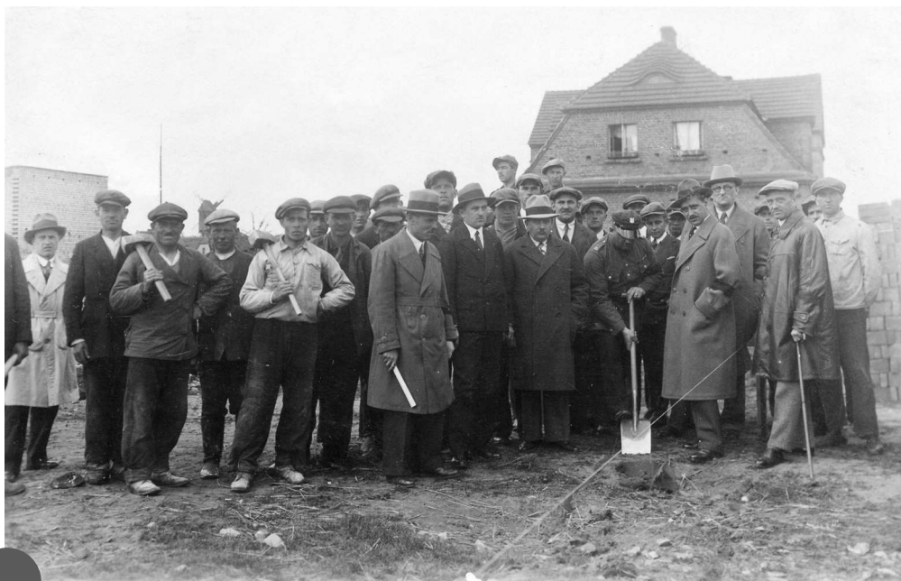
Rozpoczęcie prac budowlanych pod Dom Świetlicę im. Józefa Piłsudskiego
