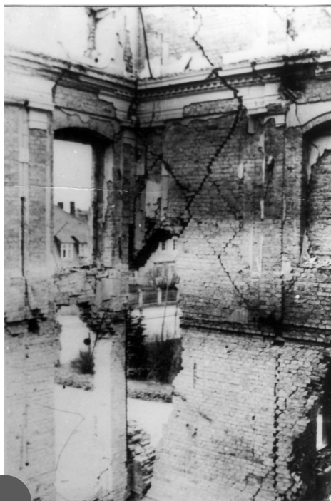
Zniszczona wybuchem aula gimnazjum
