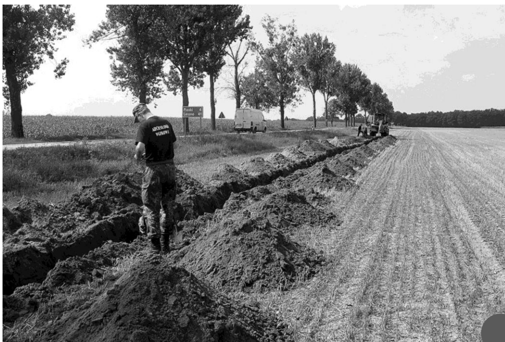
Sondaż koparką w Dąbrówce
