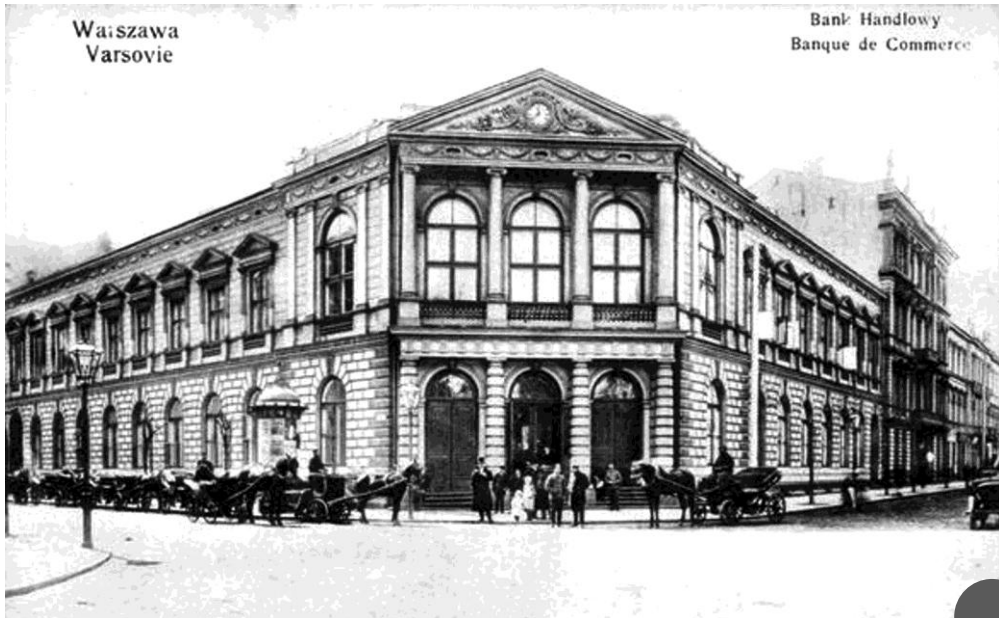
Bank Handlowy w Warszawie
